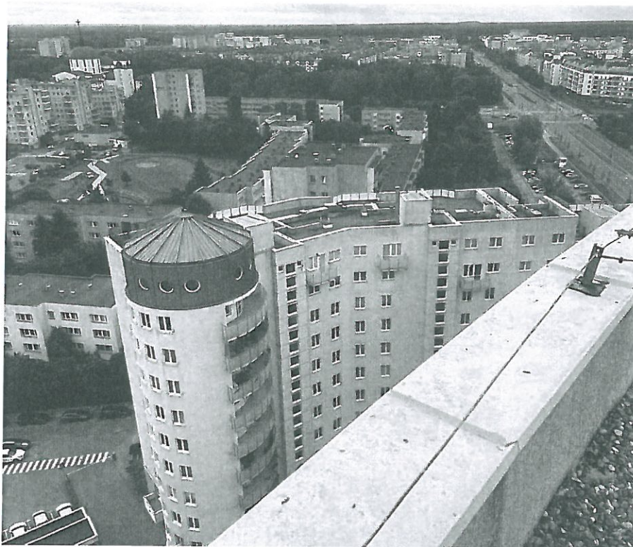
Fot.4-1. Widok na elewację oraz dach budynku mieszkalnego M1 przy al. KEN 36a.
