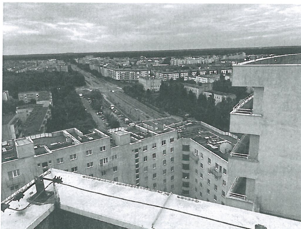
Fot.4-2. Kolejny widok na elewację oraz dach budynku mieszkalnego M1 przy al. KEN 36a.
